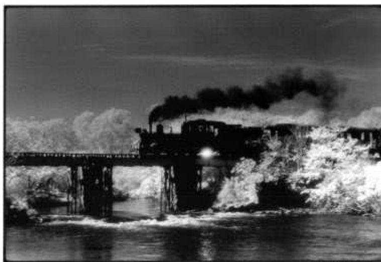
Ponte sobre o Rio Elvas em julho de 2000, com estrutura de aço envolvendo os pilares de pedra. Foto de Mariângela Chiari.
