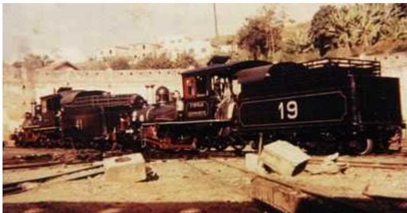
A rotunda pouco tempo após a demolição. Ao chão, os blocos de pedra que serviam de base para os pilares de ferro fundido que hoje encontram-se em fazenda de ex-engenheiro da RFFSA no Sul de Minas.
